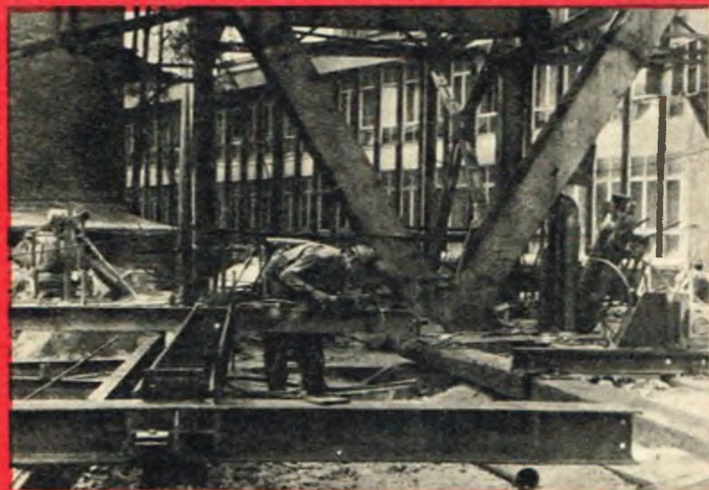
Montaż konstrukcji stalowej.
