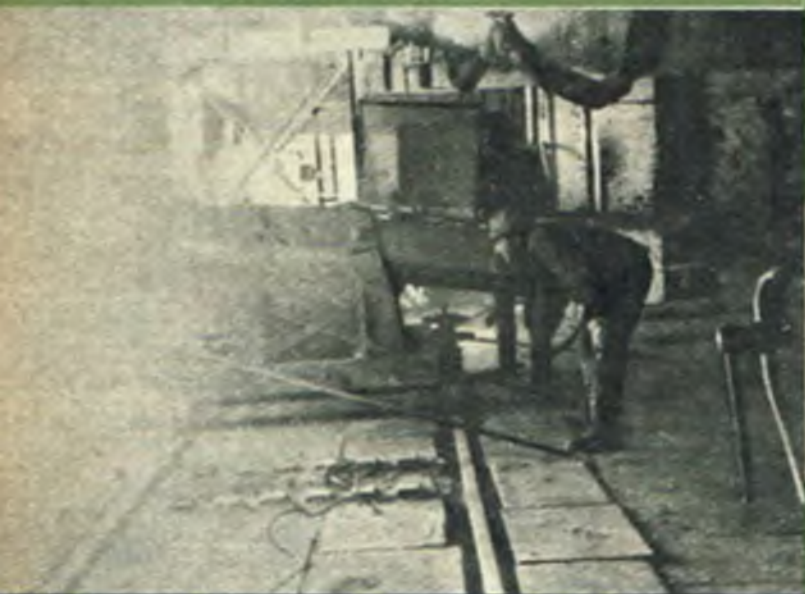
Spust ciekłego karbidu z pleca
