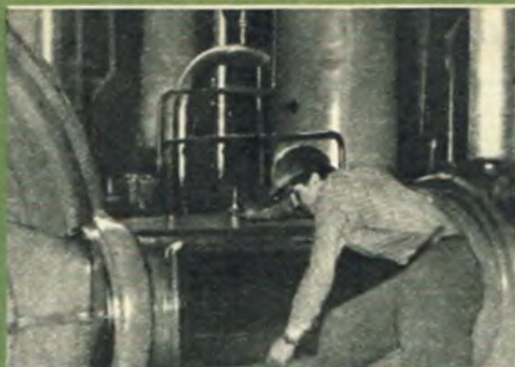
Wydział Gazów Technicznych. Sprężarka powietrza
