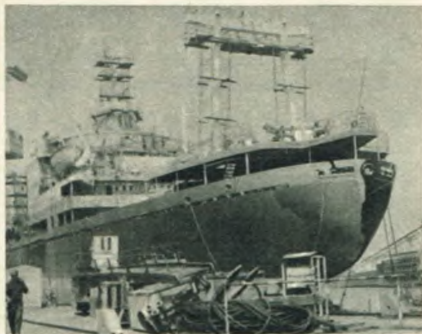
Prace przy wyposażaniu statku w stoczni gdańskiej
