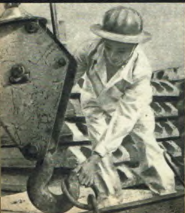
Na nowoczesnych i zmechanizowanych placach budowy
