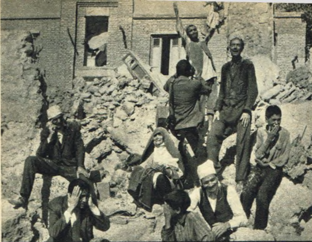
Na ruinach domów siedzą zrozpaczeni mieszkańcy irańskiej wsi Kakhak. Pod gruzami poginęli ich bliscy w czasie trzęsienia ziemi 1. IX. br.
