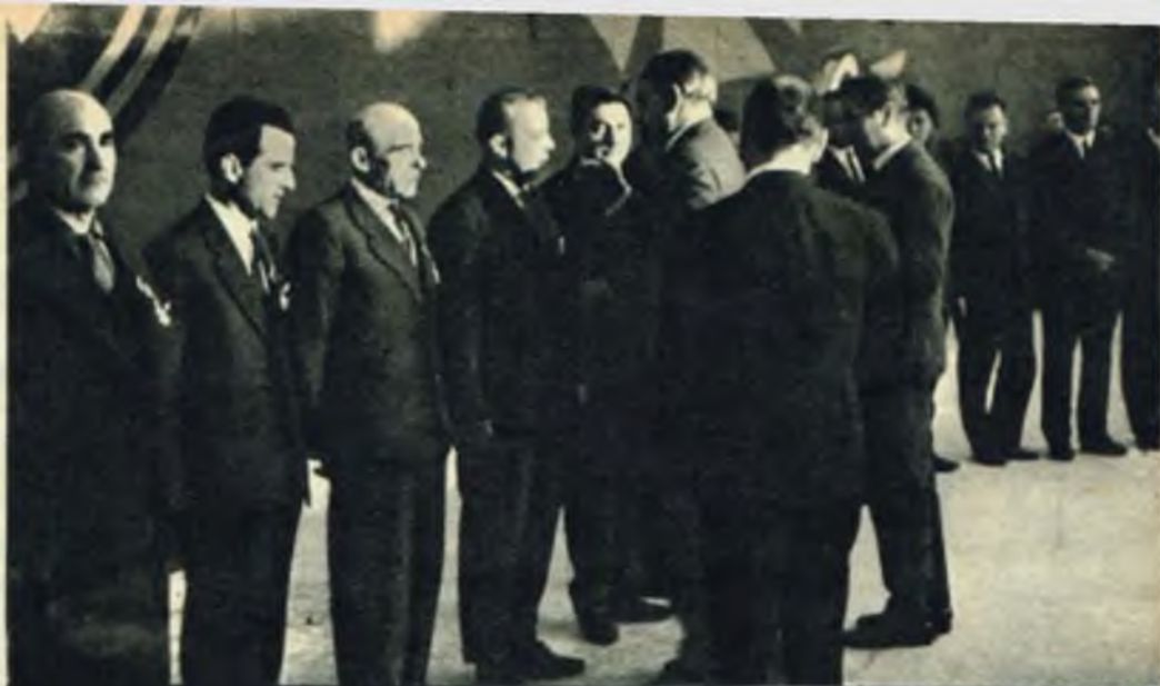
Wśród odznaczonych przy budowie OZOS byli pracownicy z Oddziału Robót Antykorozyjnych Polkat w Gdyni.
