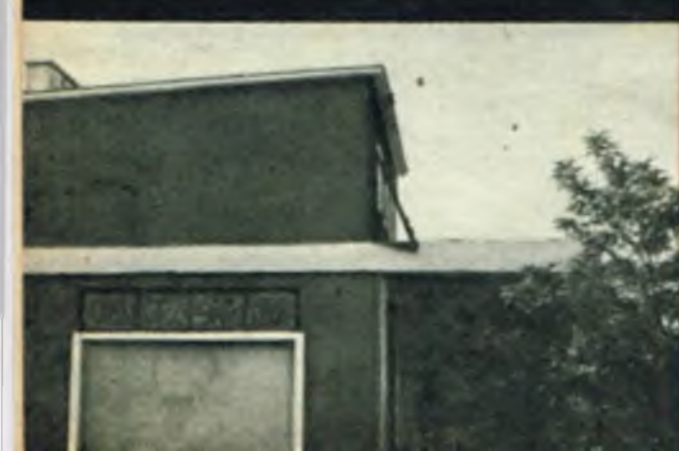
„Dom Kultury” jeszcze w budowie
