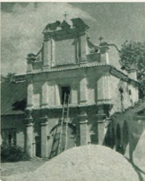
Jedynym zabytkiem jaki pozostał w Chełmie jest stara barokowa brama wiejska na „Górcie”. Dawniej przypuszczano, że względu na krzyż na niej umieszczony, że budowla ta była niegdyś kościołem. Fot. CWF
