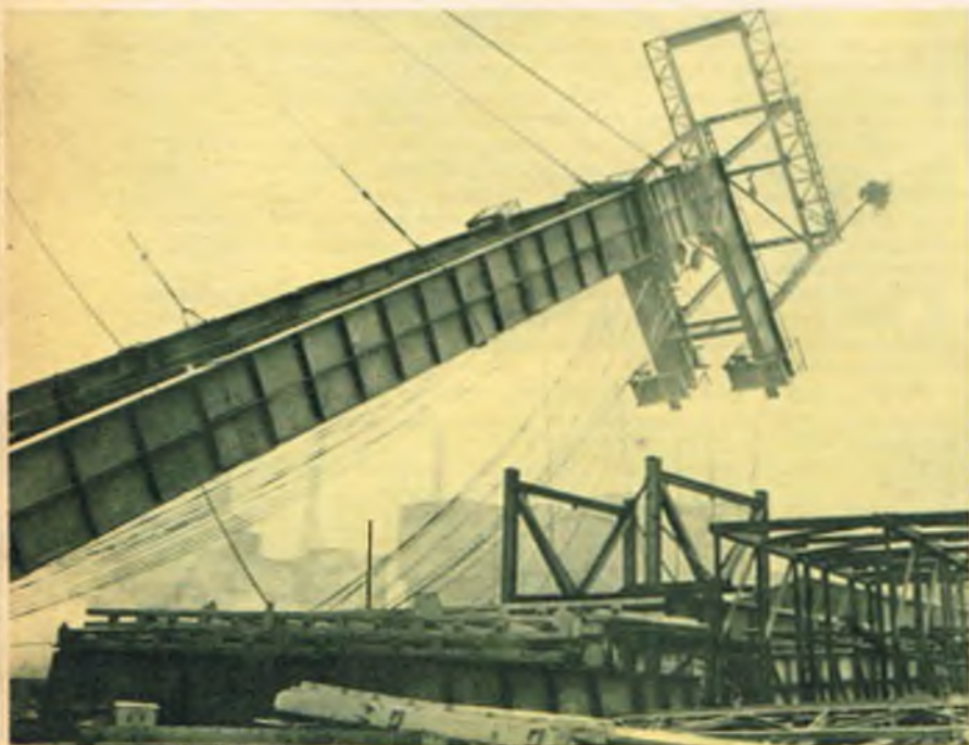
Budowa wieży szybu kopalni Makoszowy. Zastosowano tu nowoczesny system montażu, skracający czas pracy o cztery miesiące
