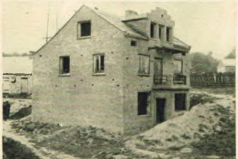
Nowa plebania, którą buduje ks. proboszcz w Dąbrówce.
