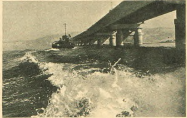
O podpory nowego mostu uderzają uparcie fale Wolgi.
