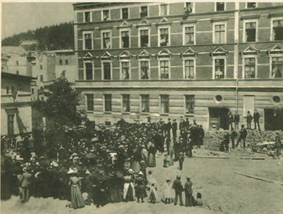
Reprodukcja zdjęcia z archiwum parafialnego — położenie kamienia węgielnego przy budowie kościoła starokatolickiego (22 lipca 1900 r.).
