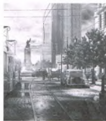
Plac Unii Lubelskiej z planowanym tu przed wojną wieżowcem Polskiego Radia w technologii VR
