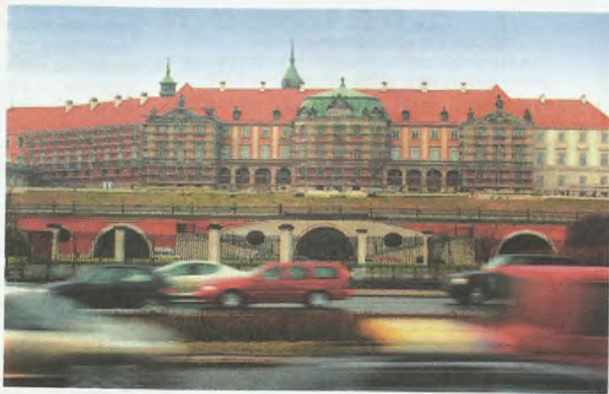
Widok od strony warszawskiej Wisłostrady. Wschodnią elewację zaczęły przykrywać rusztowania
