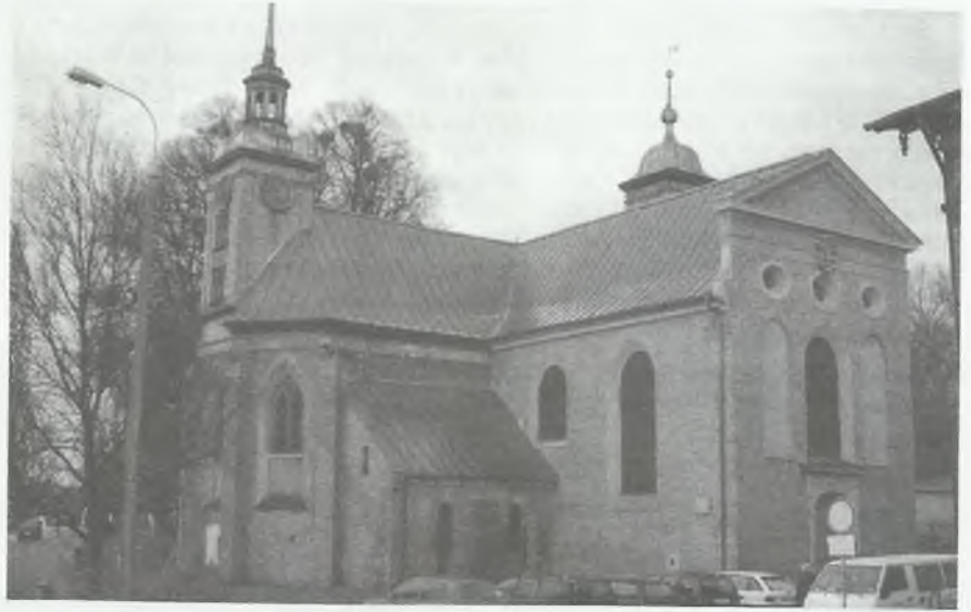
Fronton kościoła pw. Bożego Ciała po renowacji dachu, murów i stolarki drzwiowej. U góry widoczny karusz z herbem Gdańska
